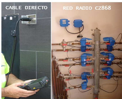
Foto 1 Equipos de lectura directa, Radio, GSM/GPRS y NB IoT
